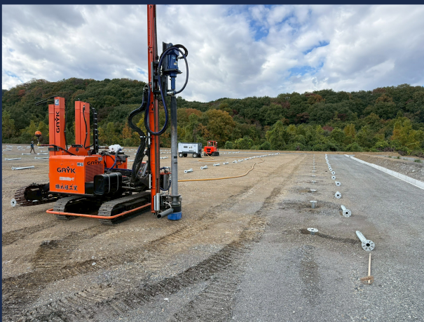
HRE4000WS【ガイク】 ダウンザホールハンマー工法
